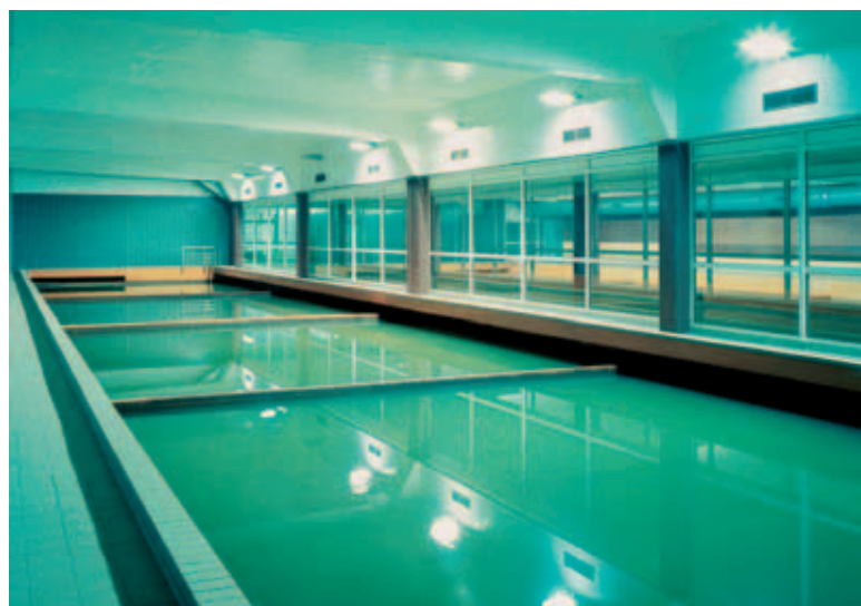
Filteranlage in einem Wasserwerk: Entfernung von Trübstoffen und daran haftenden Mikroorganismen (einschl. Krankheitserregern) und chemischen Stoffen
