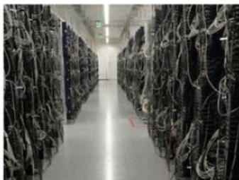
Angriffspunkt für Hacker: Rechenzentrum eines Internet-Dienstleisters (Archivfoto vom 19.4.2006). dpa
